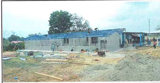
Foto 2: En este proceso se realizó el cambio de techo de la aulas del Centro Educativo.
