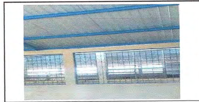
Foto 6: Colocacion de vidrio
